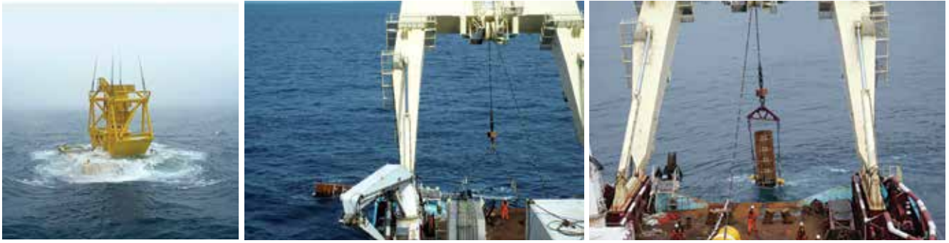
Hình 14. Đưa khung đóng cọc vào vị trí, cấu cọc nằm ngang, đưa cọc về vị trí thẳng đứng
