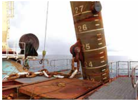
Hình 16. Nối đoạn xích cuối vào cọc
