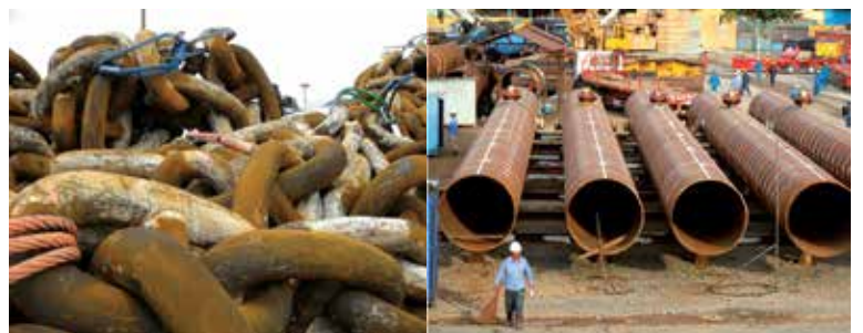
Hình 10. Tập kết xích, chế tạo cọc trên bãi lắp ráp
