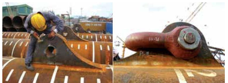
Hình 11. Kiểm tra độ vừa của ma ni vơ tại cọc
