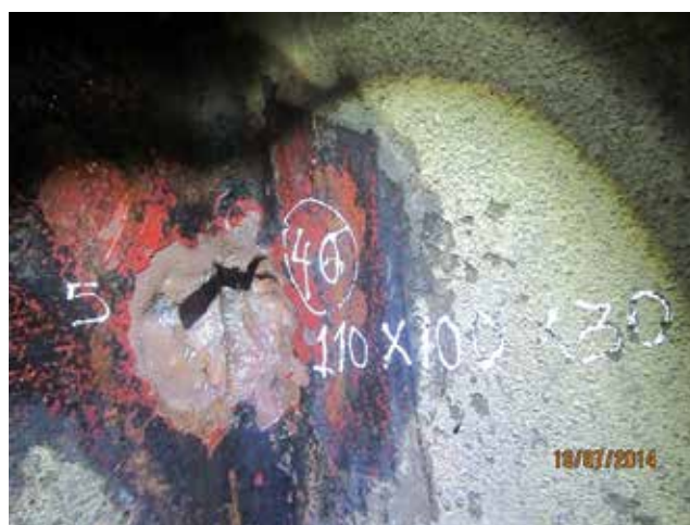
Hình 4. Hiện trạng ăn mòn bên trong tại các hộp nước của thiết bị bình ngưng trong Nhà máy Điện Cà Mau
